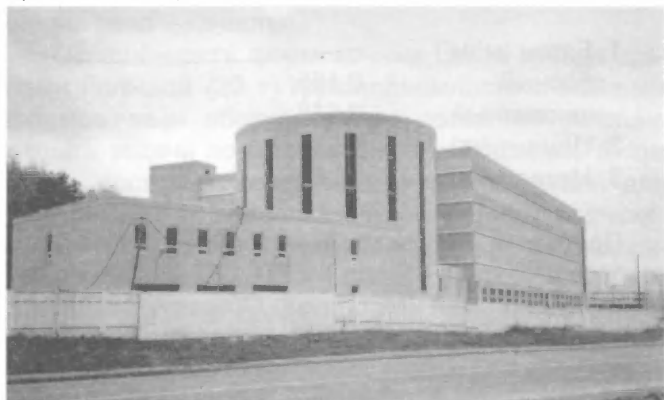
Рис. 4. Здание многоэтажного гаража в Москве
