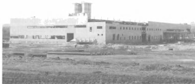
Рис. 3. Строящийся завод газобетонных блоков в г. Усть-Лабинск
